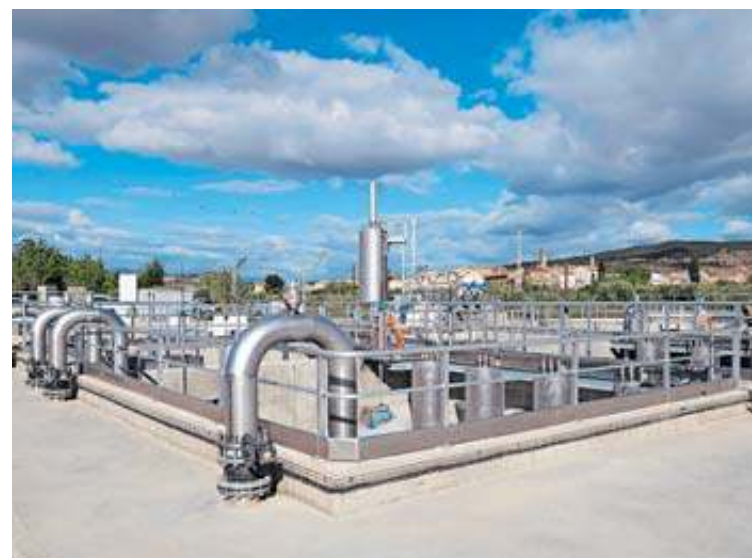
Imagen de una de las zonas renovadas de la depuradora.
