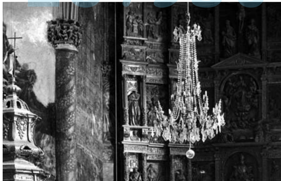
Cabecera de la parroquia de Valtierra con las pinturas murales del siglo XVIII en la capilla mayor y los pabellones de etapa rococó sobre los retablos colaterales. BILDARCHIV FOTO MARBURG
