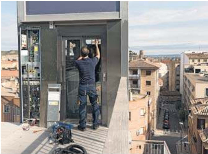
Un operario, ayer durante los trabajos de reparación del ascensor. B.A.
