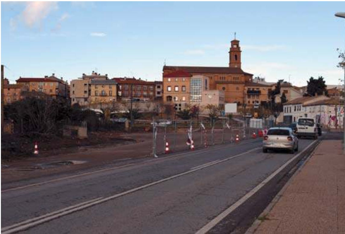
Zona donde se ubicará la nueva rotonda que se va a construir en el acceso a Murchante.
