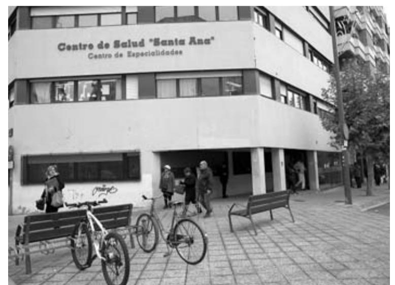
Fachada del centro de salud Santa Ana de Tudela.
