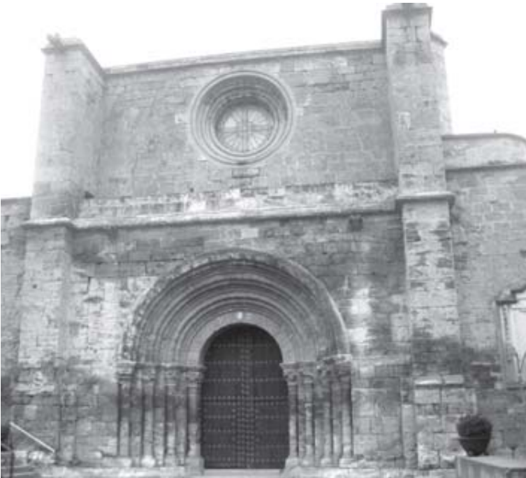
Imagen de la fachada principal del Monasterio de Fitero. ARCHIVO
