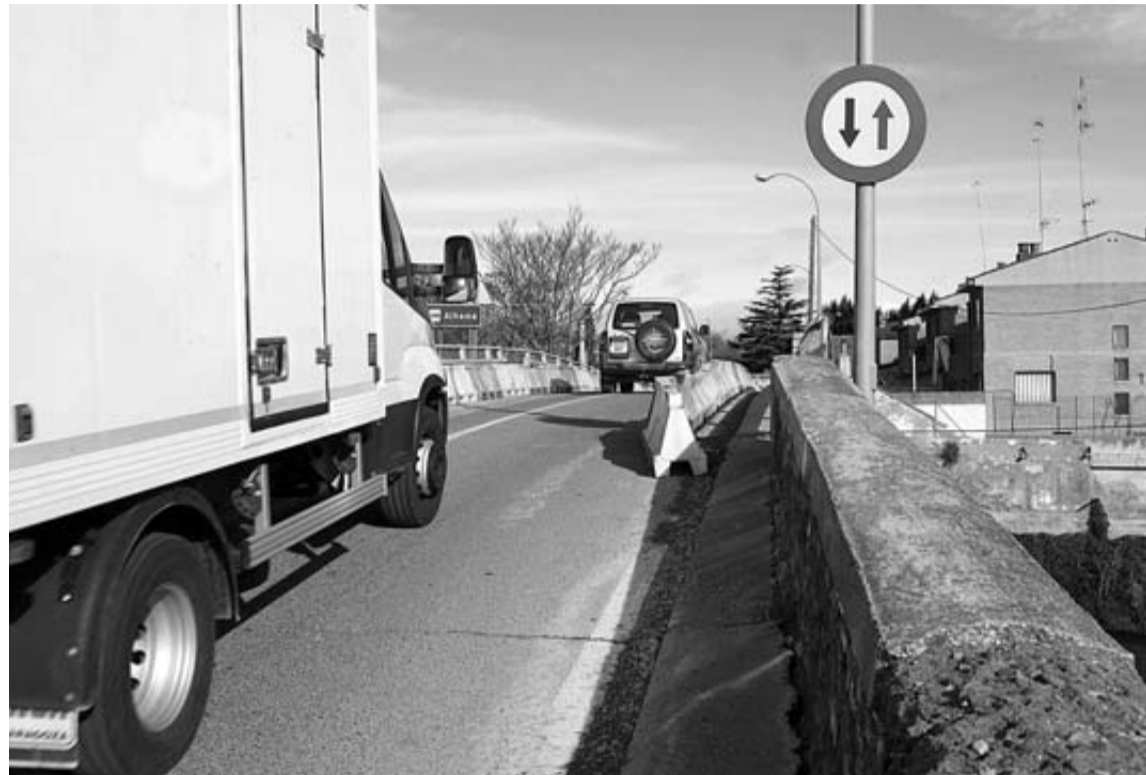
Un camión y un vehículo circulan por el puente junto a la señal que da paso alternativo.
